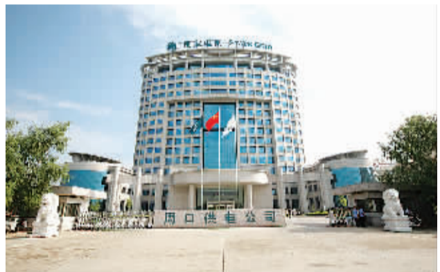
周口电力调度通信中心
