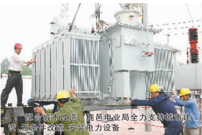
配合城市改造,鹿邑电业局全力支持城市建设,无条件改造、安装电力设备
