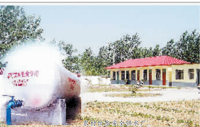
农村饮水安全供水厂。
