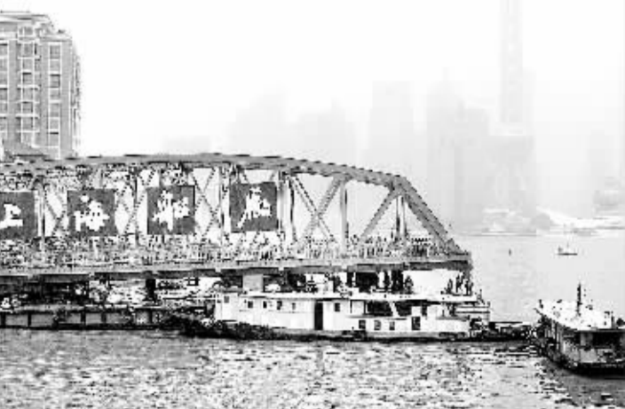
百年外白渡桥开始回归原位 2月25日,外白渡桥北段桥身在雨中停靠至原位。当日,修缮完毕的上海外白渡桥钢结构北段桥身再次“坐上”千吨驳船,从浦东的上海船厂移回苏州河原位,整个桥体复原工作将在三天内完成。始建于1907年的外白渡桥是苏州河汇入黄浦江口的第一座钢桥,也是见证上海滩百年沧桑的著名地标。
