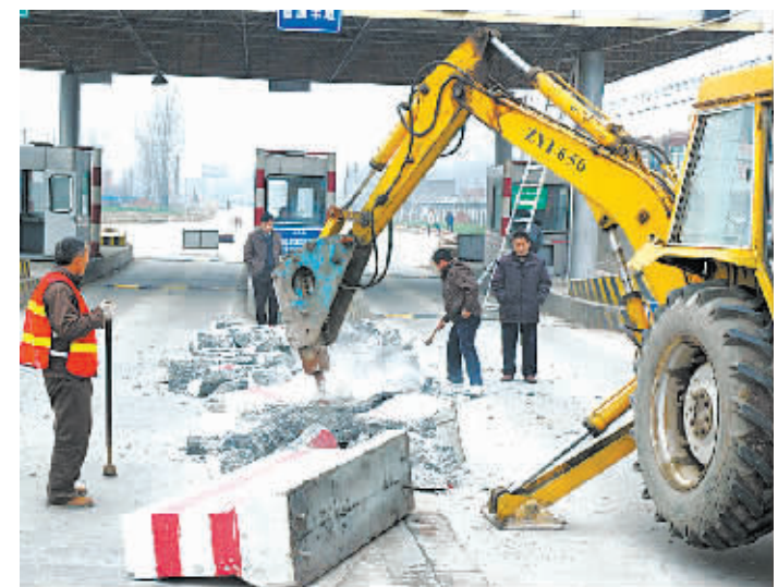
3月1日,施工机械将合(肥)水(家湖)公路收费站水泥隔离桩拆除。当日零时起,安徽省境内全部71个政府还贷二级公路收费站停止征收车辆通行费,收费站拆除工作全面启动。(新华社发)
