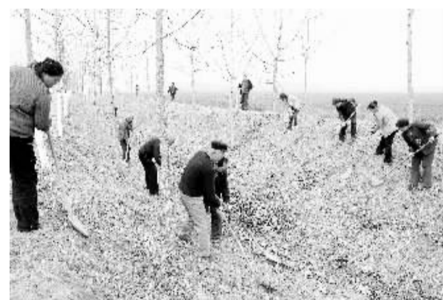
▲近日,鹿邑县太清宫镇群众对农田沟渠进行精修维护。连日来,该县积极组织人员打井、修渠、清淤等,掀起了春季农田水利建设高潮,确保早涝无忧。(蒋保庆 摄)
