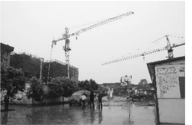
我市援建的西屏乡中学综合实验楼和教师周转房。(记者 李莉 摄)
