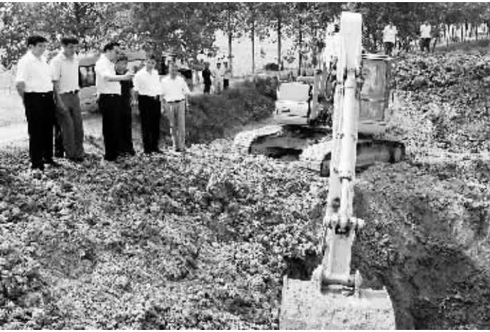
今年以来，太康县大力发展以日光温室为主的现代农业，努力形成规模优势。该县农村信用联社今年计划发放支农贷款 2.416 亿元，支助全县农民建成 1400 个日光温室。图为该县符草楼镇日光温室施工现场。
