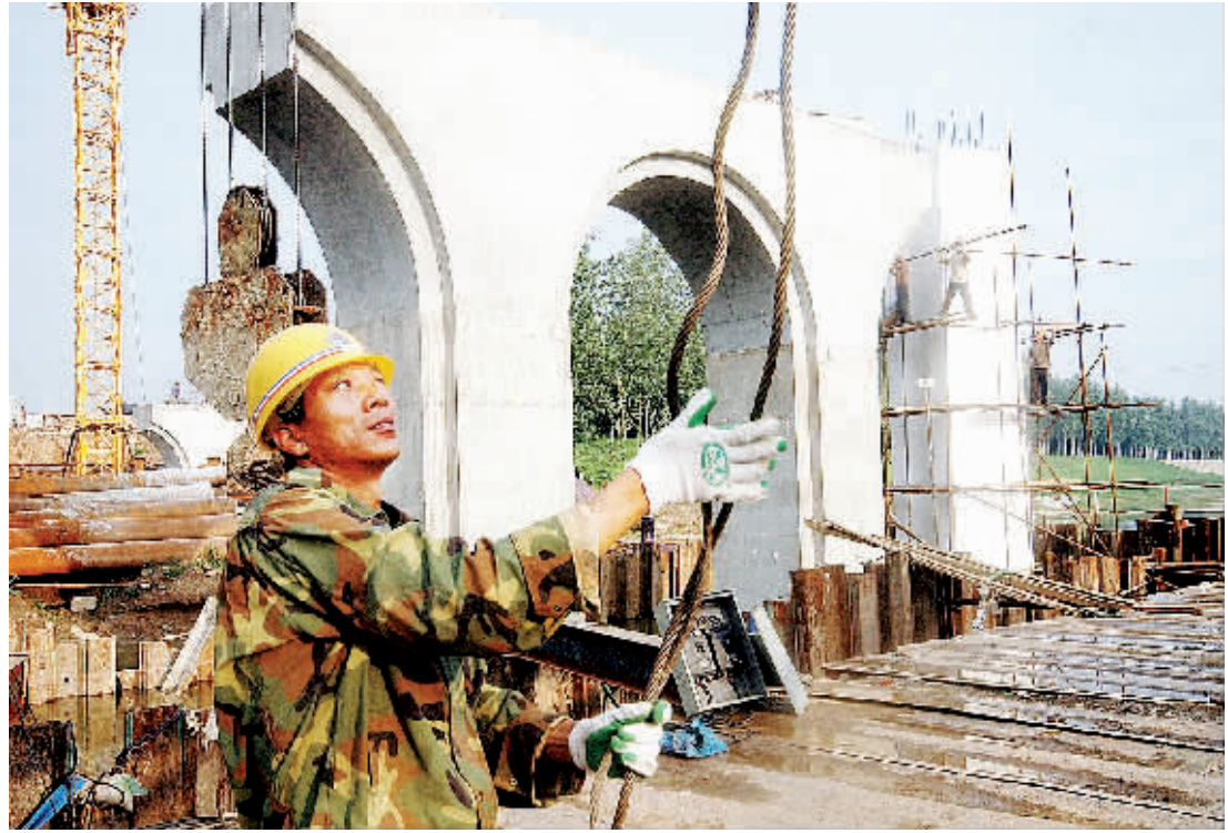
在市重点工程建筑工地上，无数来自全国各地的建设者云集周口，他们以饱满的热情工作在本职岗位上。来自南阳的温师傅告诉记者，同为河南人，能为周口重点工程建设出力，他感到很自豪。（记者 沈湛 摄）
