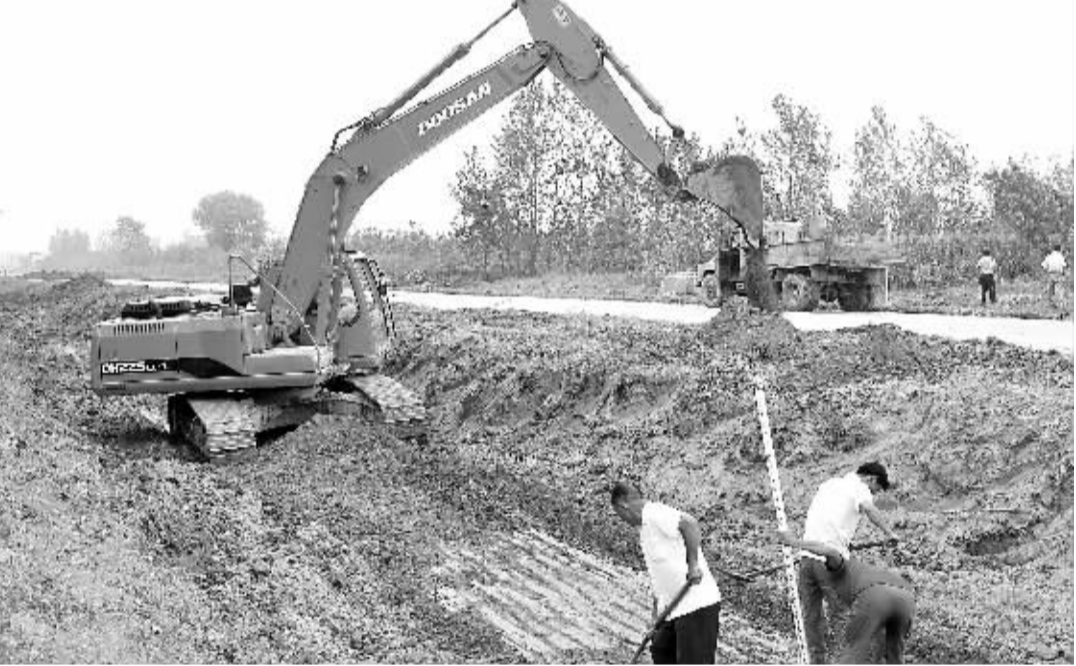
图为正在实施拓宽改造工程的园区北路。 古伟 摄
