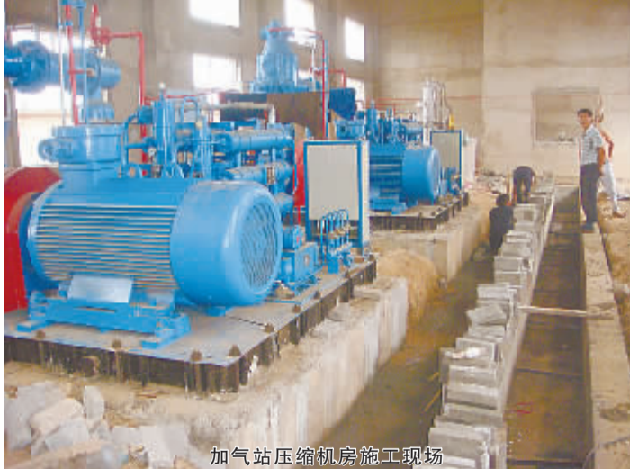
加气站压缩机房施工现场
