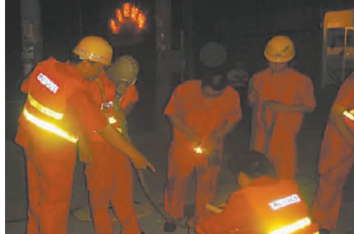
大庆路跨架管施工现场
