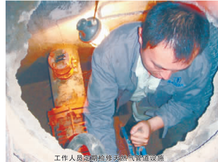
工作人员定期检修天然气管道设施
