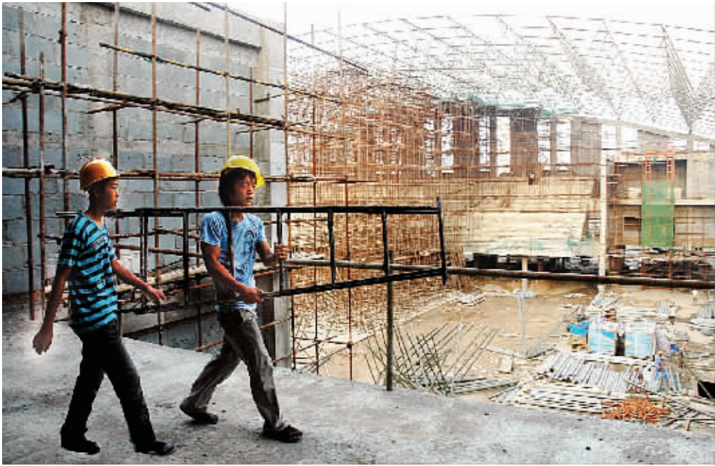
昨天下午，两名施工人员正在市体育馆建筑工地紧张工作。市体育馆建设项目是我市的重点工程，预计 2010 年年底竣工。（记者 沈湛 摄）
