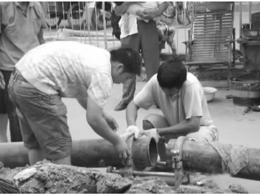
低压供水区改造现场
