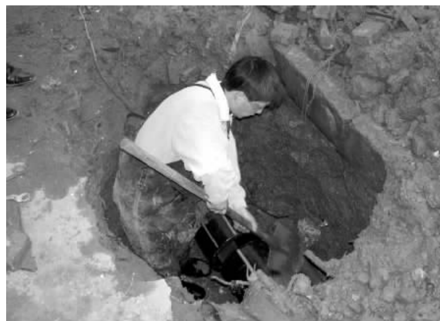
抢修漏水管道
