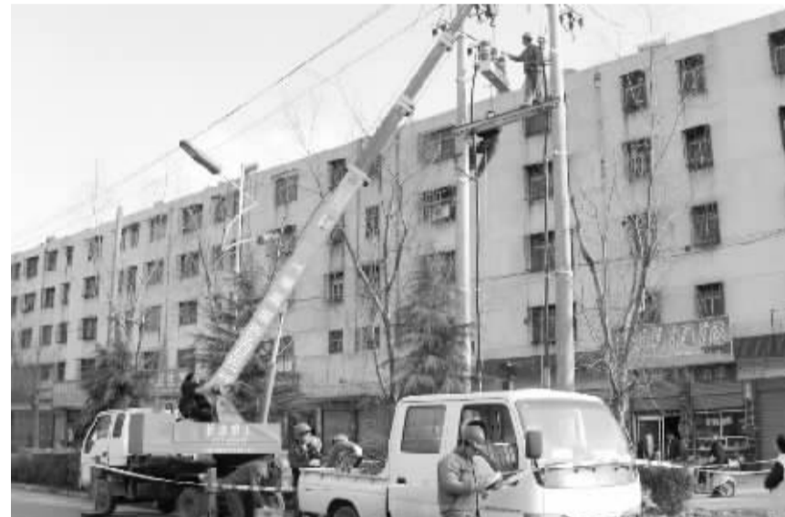
改造双电源线路,确保恶劣天气水厂供电
