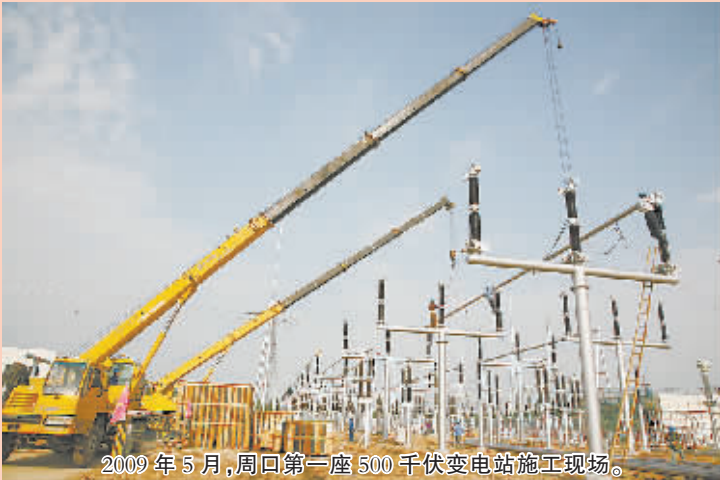
2009 年 5 月,周口第一座 500 千伏变电站施工现场。
