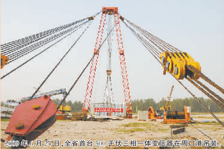
2009 年 6 月 24 日,全省首台 500 千伏三相一体变压器在周口港吊装。
