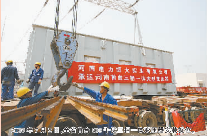
2009 年 7 月 2 日,全省首台 500 千伏三相一体变压器安装就位。
