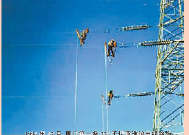
1986 年 12 月,周口第一条 220 千伏溱淮输电线路施工现场。(张宝云摄)
