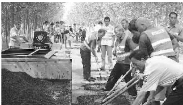
公路维护施工场景。
