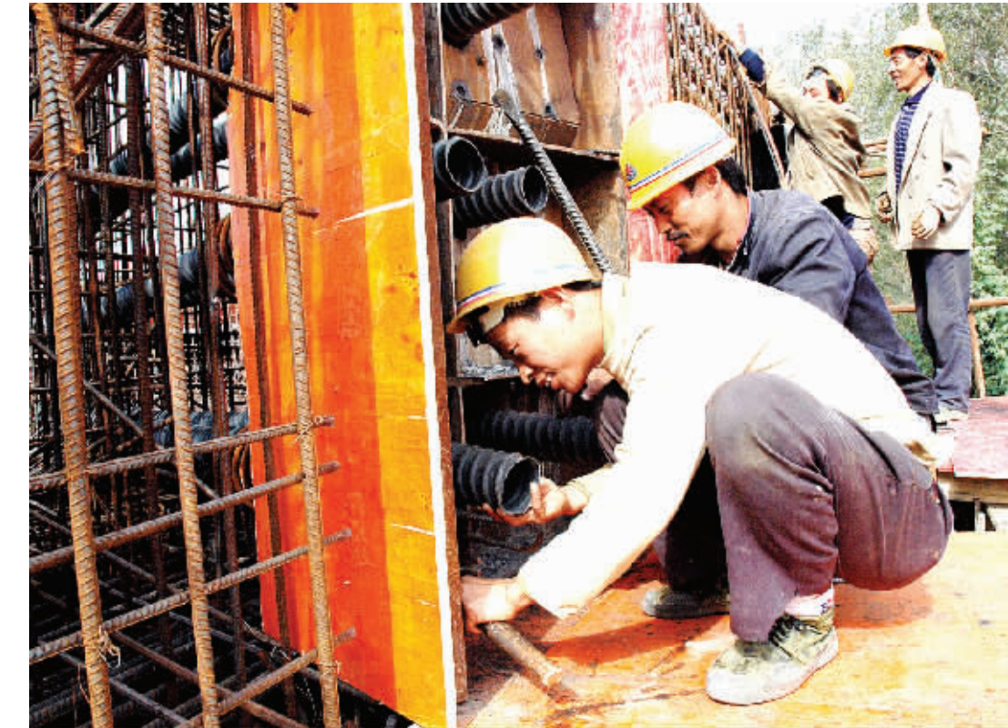
预计 12 月 31 日竣工的我市重点工程——建设路贾鲁河桥连拱桥项目目前进展顺利,现在施工进入箱梁浇筑阶段。该项目建成后,不仅能极大地改善中心城区道路网络,而且对于扩大城市规模、完善城市功能、提升城市品位都将发挥积极而重要的作用。(记者 沈湛 摄)
