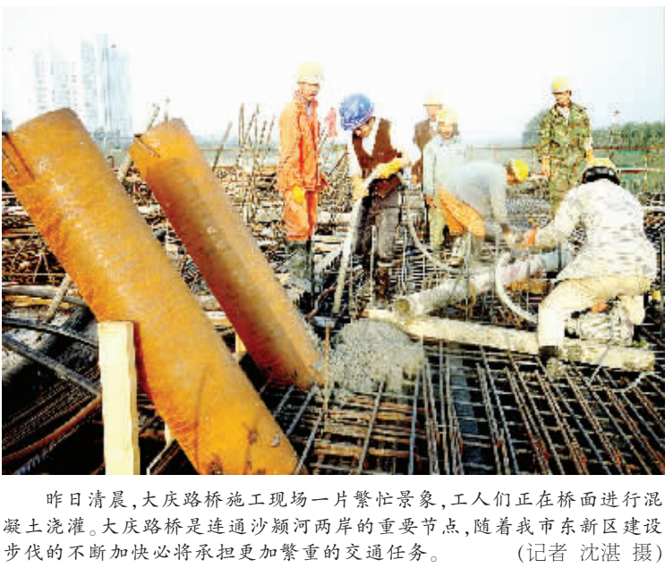
昨日清晨,大庆路桥施工现场一片繁忙景象,工人们正在桥面进行混凝土浇灌。大庆路桥是连通沙颍河两岸的重要节点,随着我市东新区建设步伐的不断加快必将承担更加繁重的交通任务。(记者 沈湛 摄)
