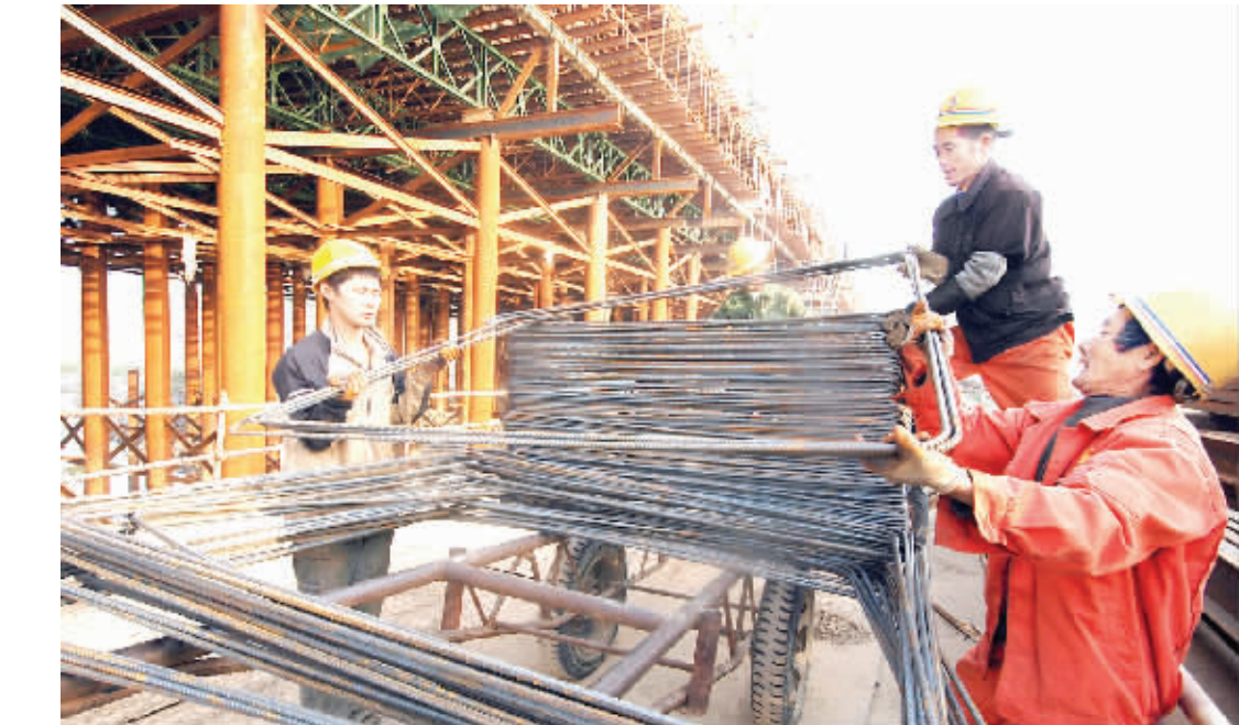
昨日清晨,大庆路桥施工现场一派繁忙景象。工人们正在忙碌地工作着,努力确保工程如期交付使用。(记者 沈湛 摄)
