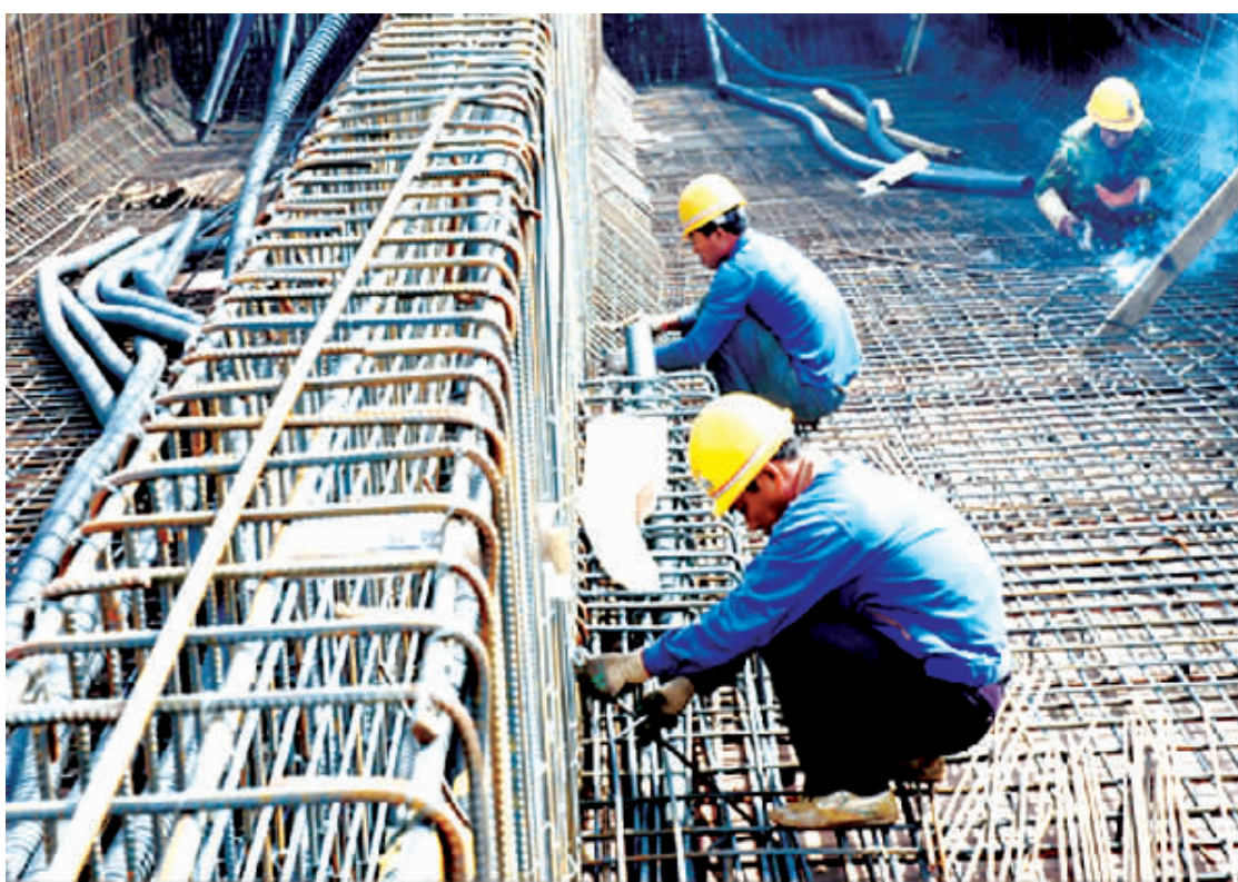
日前, 贾鲁河桥施工现场一片繁忙, 工程建设人员齐聚桥面开展桥面混凝土浇灌准备工作。贾鲁河桥是广大市民最为关心的重点工程之一, 承载着周口经济社会发展的交通重任。(记者 沈湛 摄)
