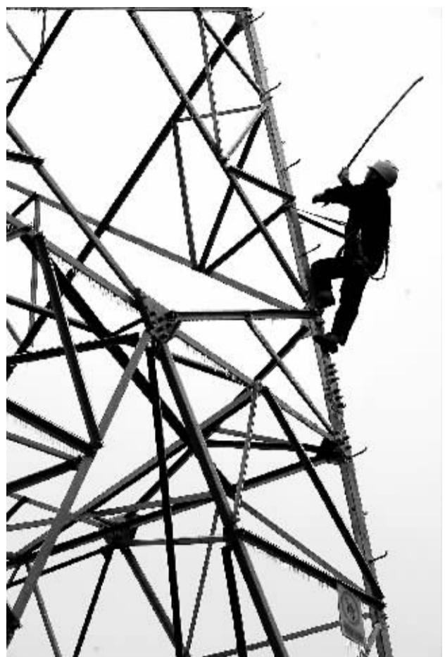
破冰特巡保电力畅通 11月18日,福建省建宁县供电公司线路巡视班工人清除电力铁塔上的覆冰。受北方冷空气南下影响,福建省建宁山区出现雨雪冰冻现象。新华社记者 彭张青 摄
