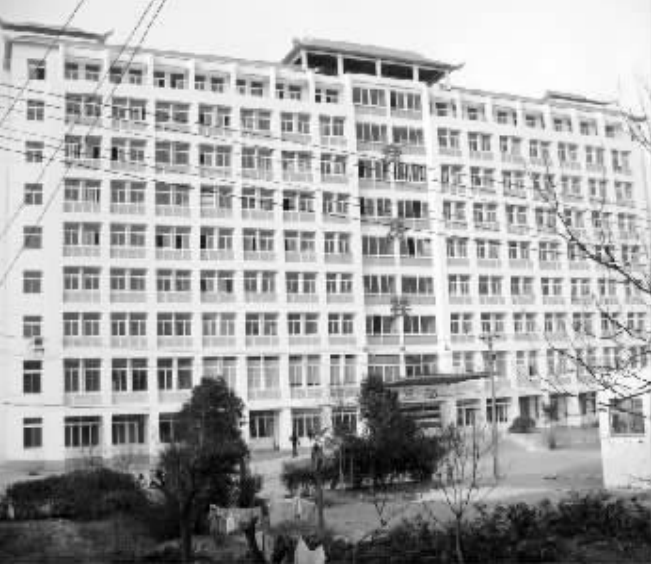
鹿邑县人民医院病房楼
