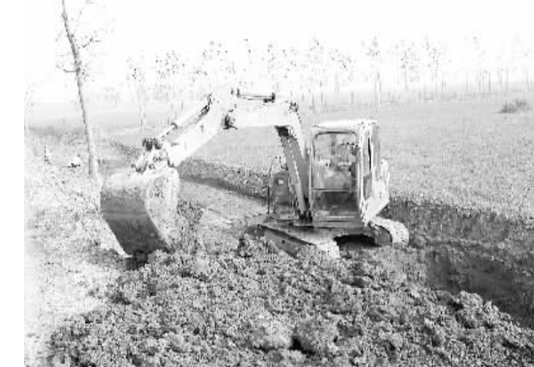
今年冬季,商水县位集镇镇党委、镇政府广泛动员群众投身到农田水利建设热潮中去,努力打造样板工程。上图为该镇群众正在农田方向清淤挖土。下图为挖土机正在开掘农田方沟的情形。(苏建广 摄)
