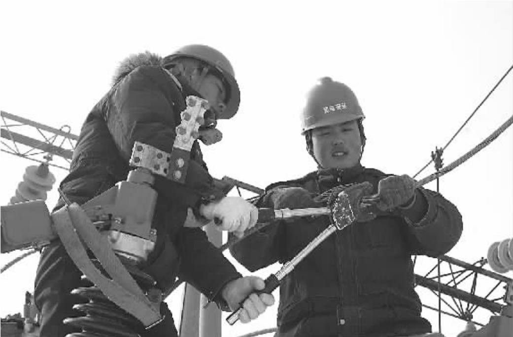
近日,鹿邑供电公司对所属35千伏变电站进行全面检修,消除安全隐患。图为该公司检修人员在认真检修设备。(张文杰 摄)
