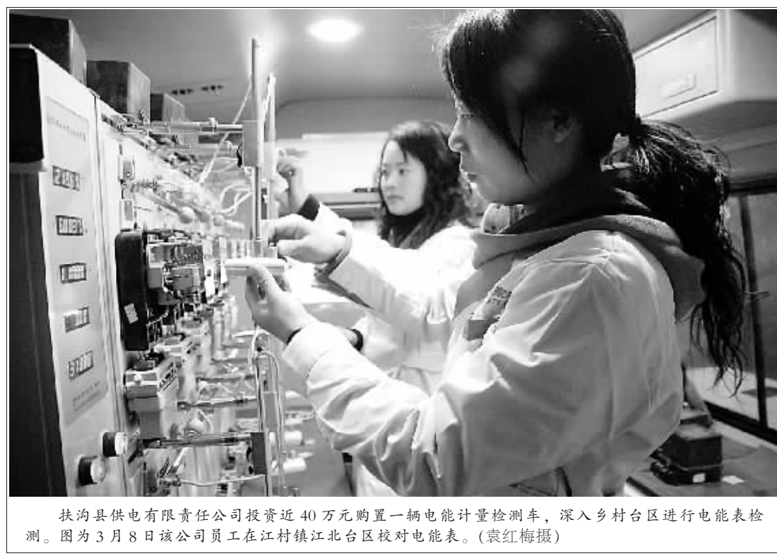
扶沟县供电公司投资近40万元购置一辆电能计量检测车,深入乡村台区进行电能表检测。图为3月8日该公司员工在江村集镇江北区台区校对电能表。(袁红梅摄)
