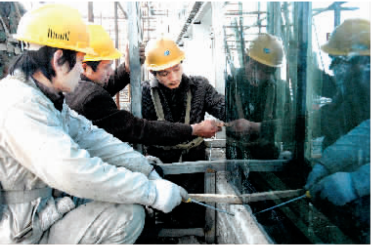
昨日,几名市体育馆外部装修工程人员一丝不苟的工作着。春暖花开,忙碌在我市重点工程的建设者们抓住有利时机,加班加点工作在线。(记者 沈湛 摄)
