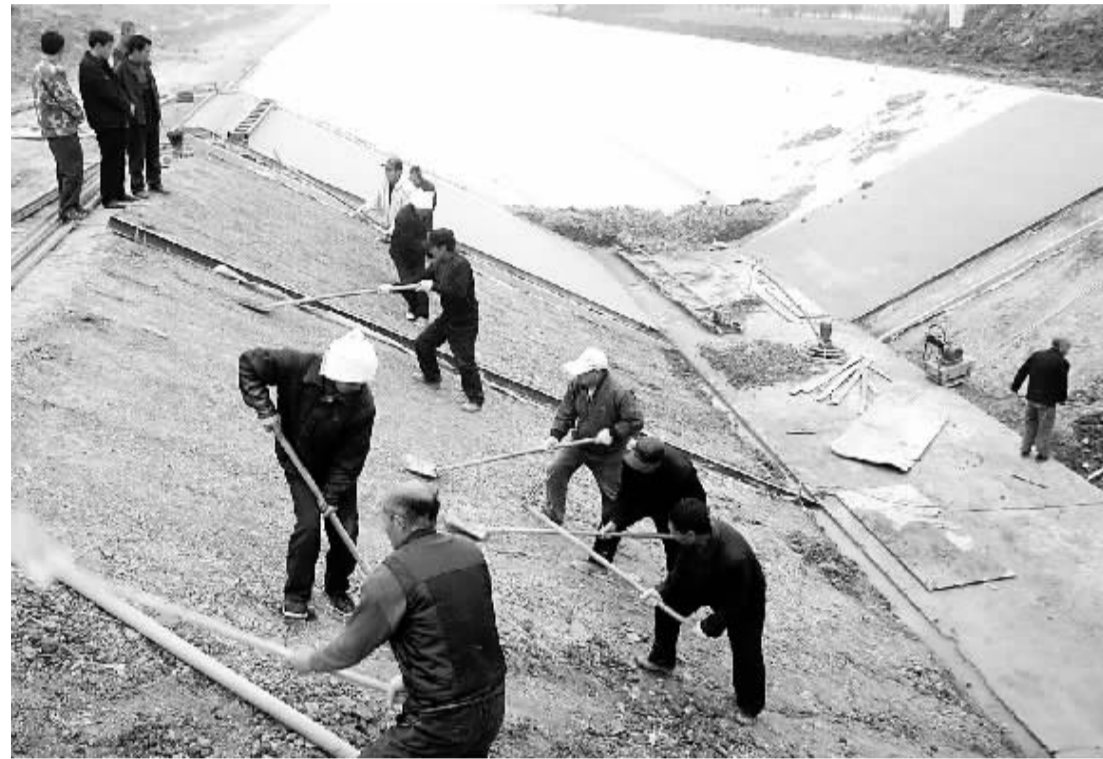
沈丘县为了确保47万亩农田灌溉问题得到根本解决,目前渠道防渗衬砌8900米,渠道清淤1400米等措施正在实施中。(记者 沈湛 摄)
