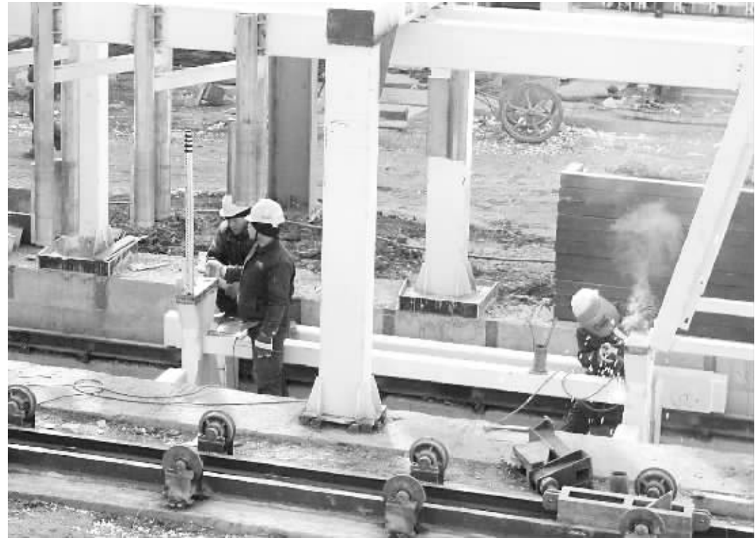
近年来,川汇区坚持“工业兴区”理念,积极引导推动产业集聚区合理有序建设和发展,加速工业化和城市化互动融合,着力推进城乡一体化建设进程,使产业集聚区成为招商引资、优化结构、调整布局的载体和平台。图为川汇区某工厂车间里的工人正在紧张施工。(记者 李寒 摄)
