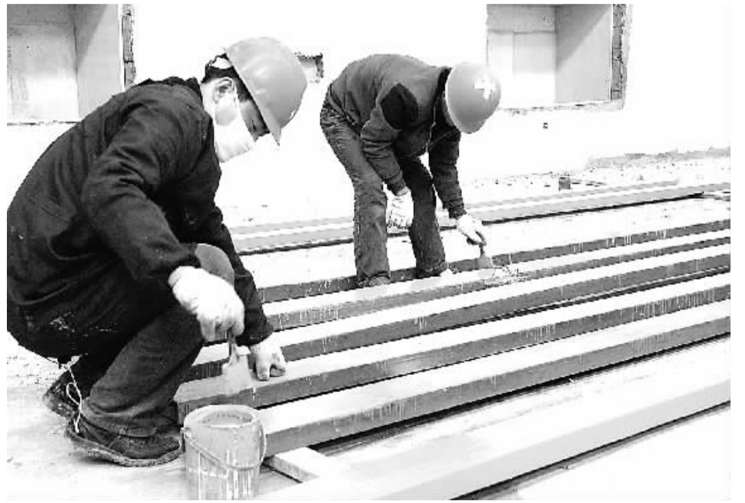
昨日,两名建设者忙碌在市体育馆一线工地。他们通过不懈努力,一所挺拔、多功能的综合性体育馆不久将展现在市民面前。(记者沈湛摄)
