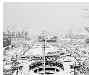
海世博会即将开幕 见证世博园区8年巨变 这是2008年12月17日拍摄的正在建设的世博园区标志建筑“轴四馆”全景
