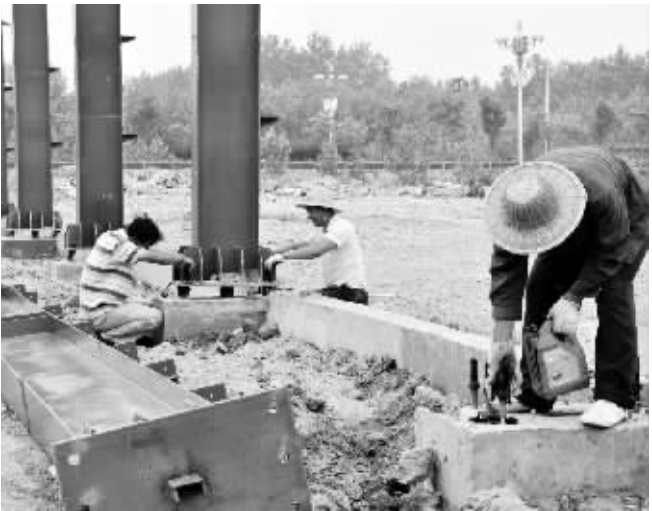
河南护理佳纸业有限公司建设项目 该项目占地300亩，新建生产车间3万平方米，新上生产线2条。总投资3亿元，2010年计划投资1.6亿元。工程要求，6月15日前所有立柱全部完工。工程进展情况：截至6月6日，该项目南侧围墙砌筑基本结束，正在外粉，北侧2000平方米原料库38根立柱安装结束，开始安装横梁，7000平方米成品库76根方柱3次浇筑结束，四周联系梁正在浇筑。图为工人们正在安装钢制立柱。
