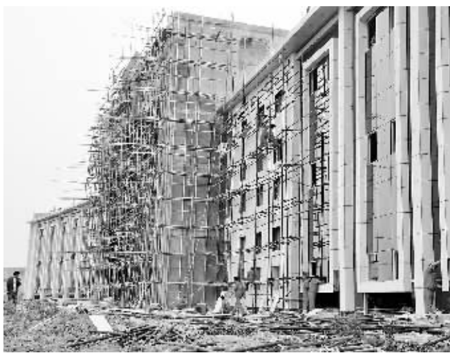
河南所望实业发展有限公司高端洗护用品建设项目 该项目年产高端洗护用品3000万瓶，总投资2.3亿元，2010年计划投资1.7亿元。项目要求，6月1日开始安装设备，6月30日试生产。项目进展情况：综合楼外墙刷白基本结束，宿舍楼外墙正在刷白，制瓶车间正在外粉，厂区道路硬化结束。图为工人们正在安装综合楼南墙两侧玻璃。
