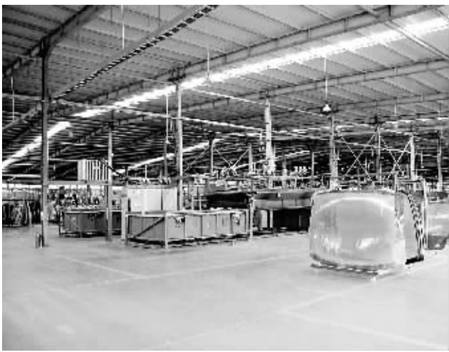
河南亚华玻璃公司高档轿车安全玻璃生产线二期工程 该项目年产100万套轿车安全玻璃，总投资1.3亿，2010年计划投资4200万元。项目要求，6月15日前新进一条高档轿车玻璃生产线，开始安装。项目进展情况：截至目前，二期工程设备安装结束，正在编程，职工正在岗位培训。图为该项目生产车间一角。
