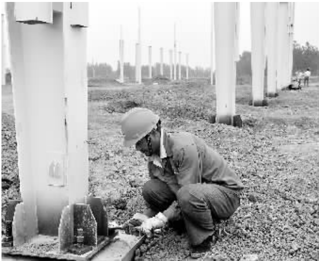
辅仁药业集团总部基地壁制剂生产中心建设项目 该项目占地400亩，新建制剂车间等基础设施3万平方米及生产线。总投资4.5亿元，2010年计划投资2.1亿元。工程要求，6月15日前厂房封顶。截至6月6日，1号厂房立柱部分购进，4号厂房30个立柱3次浇筑结束，墙基础垫层浇筑基本结束。图为工人们正在加固钢制立柱。
