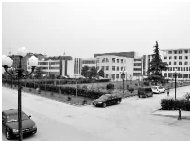
产业集聚区服务中心及职工生活服务中心建设工程 该项目总投资8000万元。工程要求，6月10日前完成建设。项目进展情况：截至6月6日，该项目建设工程基本结束，正在进行扫尾工作。图为即将投入使用的产业集聚区服务中心及职工生活服务中心。
