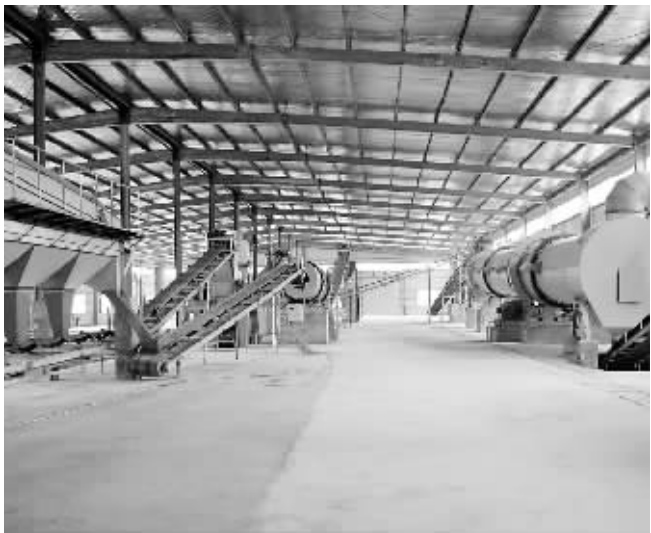
周口龙飞生物科技发展有限公司生物有机肥项目 该项目年产生物有机肥15万吨。总投资6000万元。工程要求，6月15日前投产。项目进展情况：目前，生产设备安装结束，正在调试，生产原料已购进，厂区道路硬化结束，电力线路安装完毕。图为生产车间一角。
