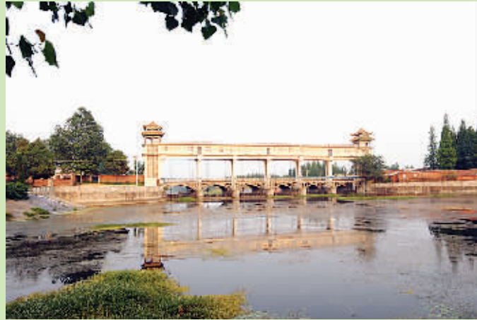
汾河姜堤闸桥，位于项城市高寺乡姜堤店南汾河上。该处原有一座五孔石拱桥，始建于明嘉靖十八年（1539 年），为姜庄南
