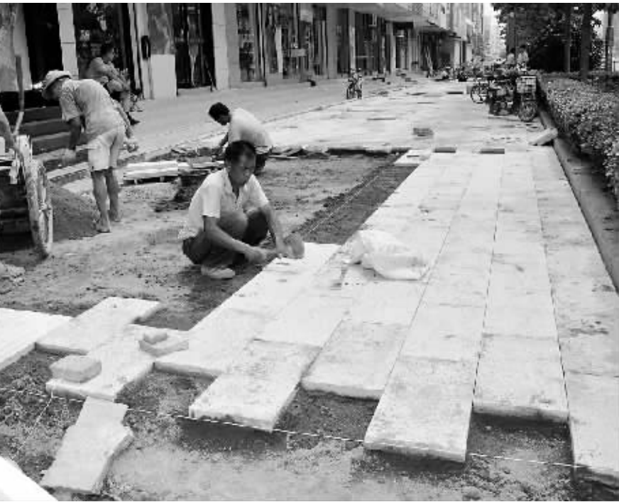
人行道“整容” 昨日,在市区七一路中段,施工人员在抓紧时间给人行道铺设天然花岗岩。据市城管局工作人员介绍,为了美化城市道路,市政府斥资将七一中路上人行道的残砖全部拆除,换上美观坚固、透水性能较好、遇水较易挥发的天然花岗岩。(记者 王映 摄)
