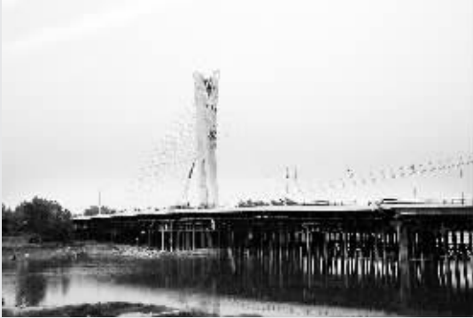
左图:工人在大庆路桥上紧张施工。
