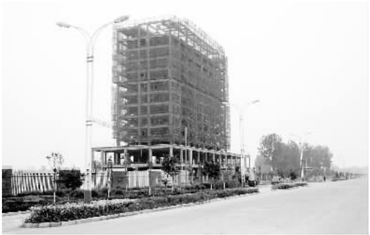
为便于服务企业,沈丘县专门在工业集聚区投资兴建综合大楼。综合楼下半部分为园区办公室,上半部分为各企业职工提供住宿。图为综合大楼主体工程已竣工。
