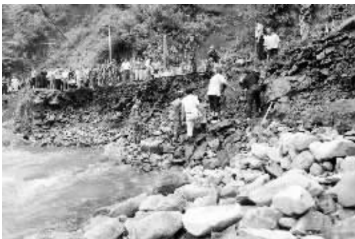
安徽休宁：快速打通生命保障线 7月10日，驻休宁某部官兵和当地群众在汉瑛公路抢修现场填补路面缺口。7月8日，安徽休宁县遭遇特大暴雨，造成31公里长的汉瑛公路出现50多处塌方，瑛尖乡对外交通完全中断。休宁县紧急组织干部群众和驻地官兵等300多人全力抢修，到10日16时，行车便道已经全部打通。
