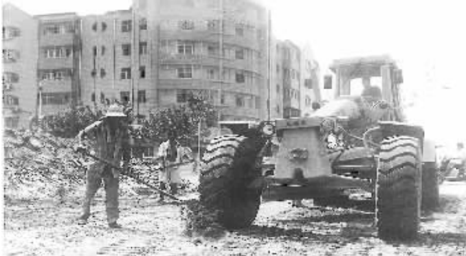
七一路改造工程现场
