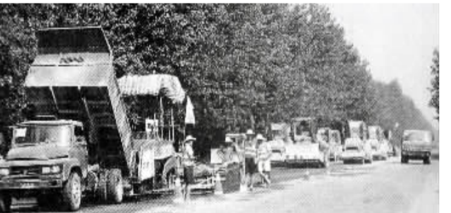
6月23日,周项路在酷暑中变颜。图为机械化施工现场。
