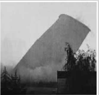
▲10月26日上午9时30分,在市区七一西路周口隆达发电公司大院内,随首一声巨响,2台2.5万千瓦和1台5万千瓦的小火电机组烟囱冷却塔瞬间倒下,标志着我市“上大压小、节能减排”迈出了关键一步。
