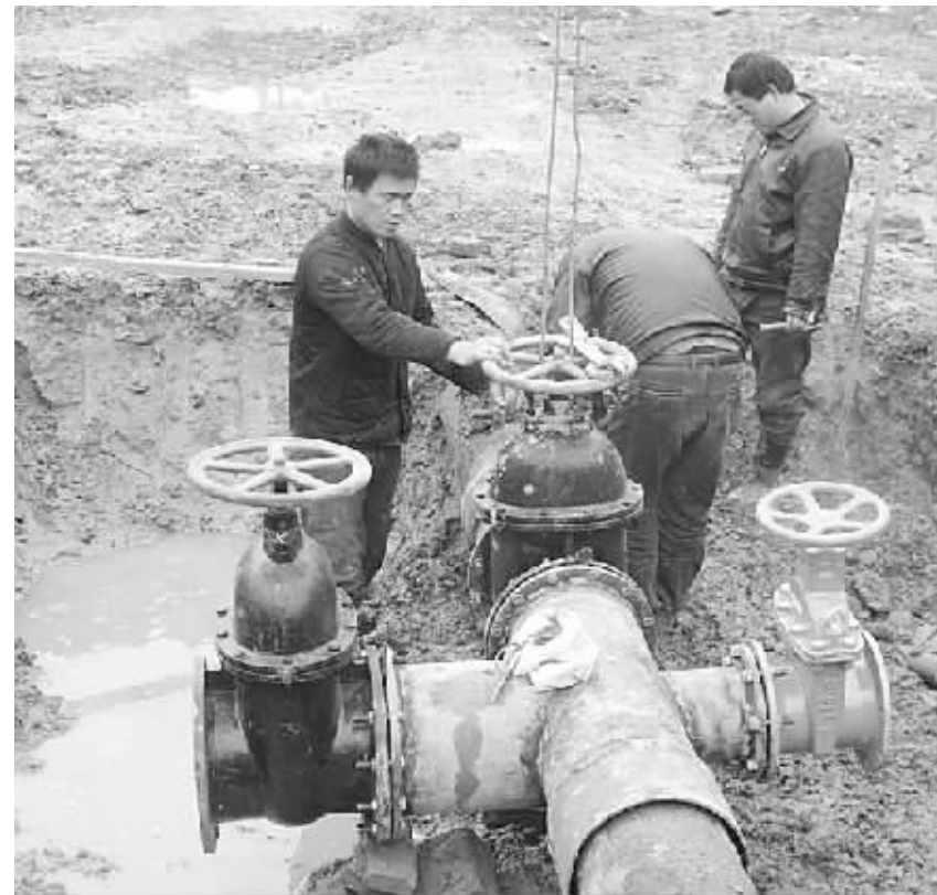
供水管道安装施工现场
