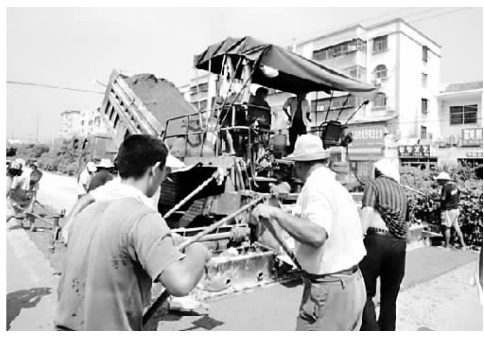
金海大道改造工程目前已经进入水泥稳定碎石铺筑阶段。为了加快工程进度,指挥部将和监理单位一道督促施工单位,克服汛期多雨等不利因素,抢抓工期、保质保量,争取使工程早日通车,彻底改善周边居民出门难的问题。 (杨玉洁 李艳丽 摄)
