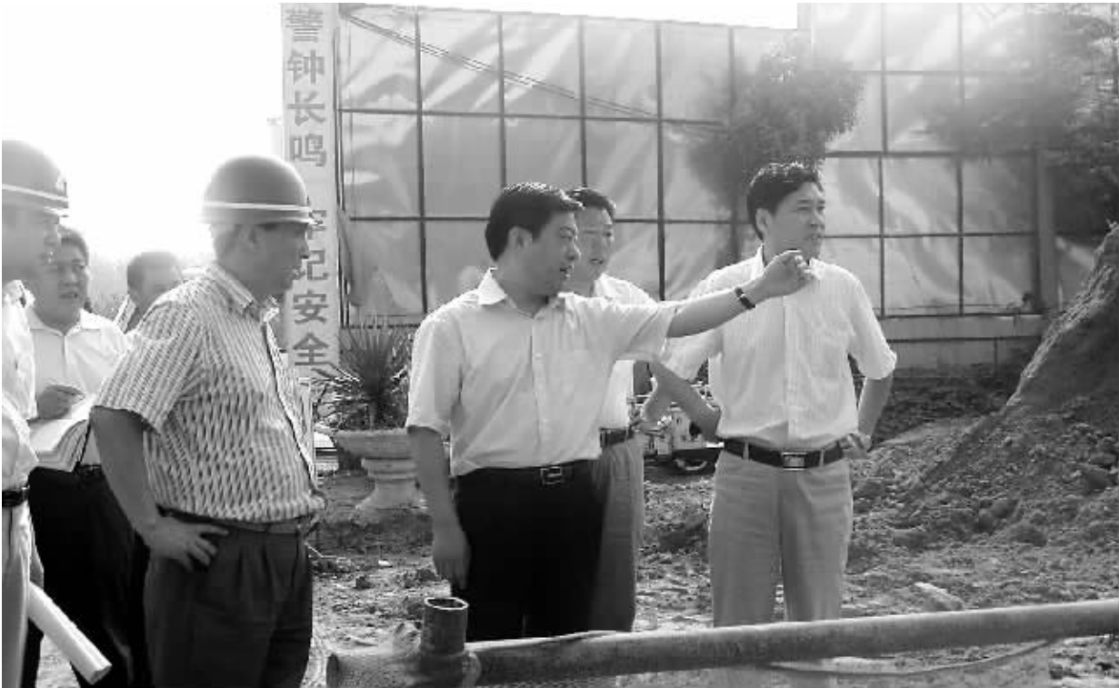
县委书记杨廷俊带领建委、城管局、国土局等单位负责人深入施工工地察看工程项目进展情况。(实习生 张启令 摄)
