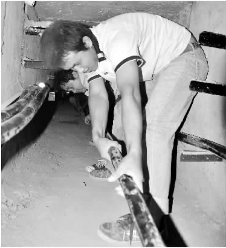
9月9日,在通泰纺织产业园,工作人员在地下通道内加班加点铺设线缆,以保证10锭精纺梳项目按时试车。(刘俊涛 摄)
