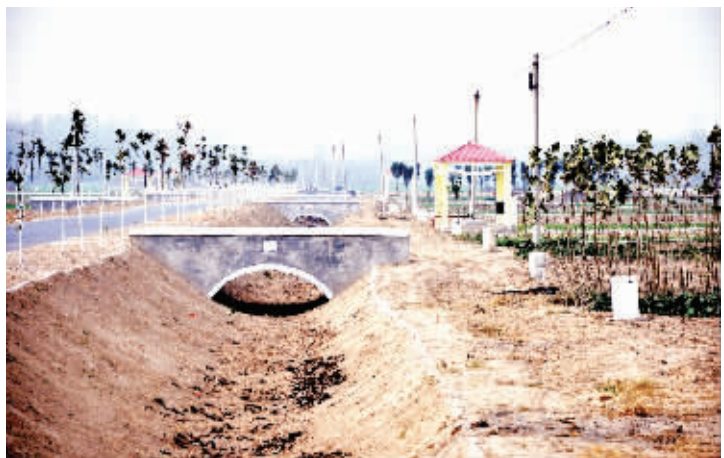
昨日，记者在西华县农资综合补贴扶持小型农田水利示范区看到，整个小区内管网配套合理，沟渠、桥梁、机井、地理水管及给水栓布置井然有序。该县不断提高运行经营管理水平，促进了农业增产增收。（记者 沈湛 摄）
