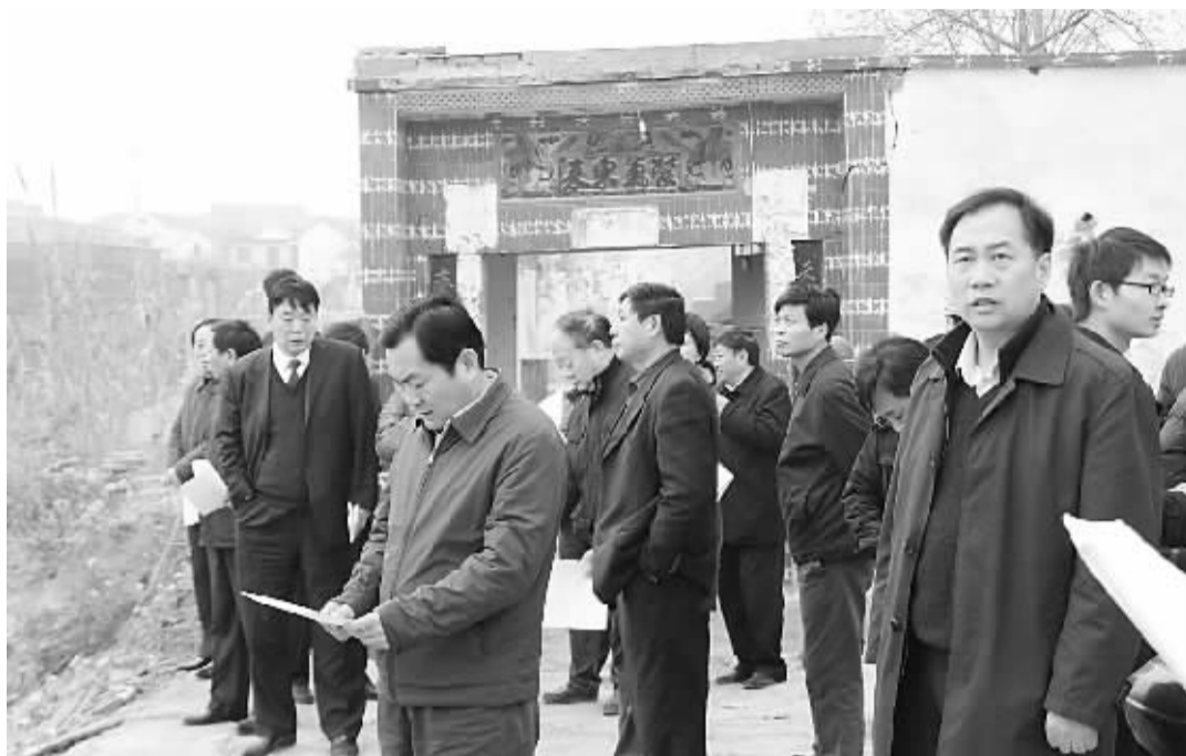
12月13日,县领导在太康县万鹤斋·天宁购物公园工地察看。当日,县领导王国玺、唐广辉、董自生、崔世岭等,先后到张王村、万鹤斋·天宁购物公园、中汇江南印象等项目施工现场,察看城市建设工作。太康县住房和城乡建设局、发改委、电业局、国土局等单位主要负责同志陪同。察看结束后,参加察看的全体人员在常委会议室对全县城市建设工作进行了座谈。(刘俊涛/文 王高志/图)
