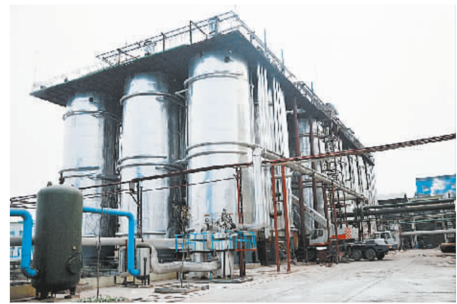
河南金丹乳酸科技有限公司年产10万吨高品质L-乳酸工程项目总投资3亿元,项目17个工程已于今年10月份全部建成并投产运行。该项目新增销售收入9.5亿元,新增利税1.5亿元。
