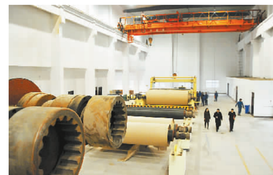
河南省龙源纸业股份有限公司开工建设的年产20万吨高强瓦楞原纸项目,计划总投资2.56亿元,建成后新增产值6.2亿元,新增利税6500万元,安置就业人数200余人。截至目前,各项工作进展顺利,现已试车投产。
