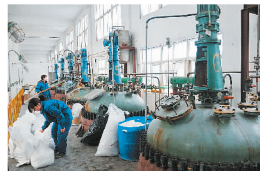
河南蜀中制药有限公司无菌原料药技改扩建设项目于2009年8月开工建设,该项目占地面积95亩,总投资2亿元,目前已完成投资1.2亿元,建成大型标准车间、质检楼、办公楼2万平方米,目前生产设备正在安装调试。
