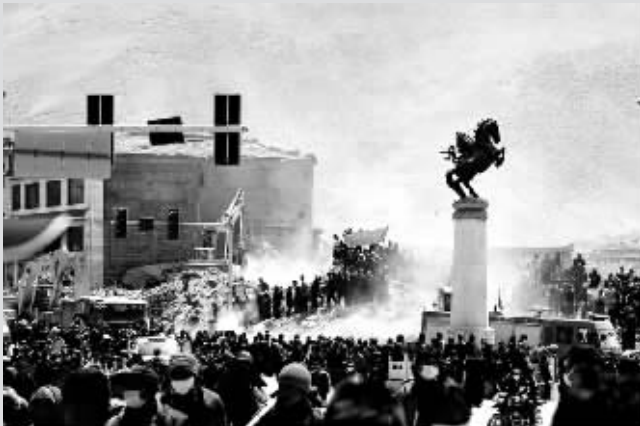
救援人员在青海玉树结古镇一处地震废墟上搜寻幸存者(2010年4月18日摄)。
