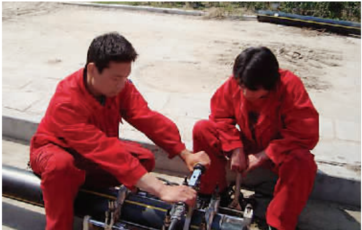
天然气公司工作人员紧张施工
