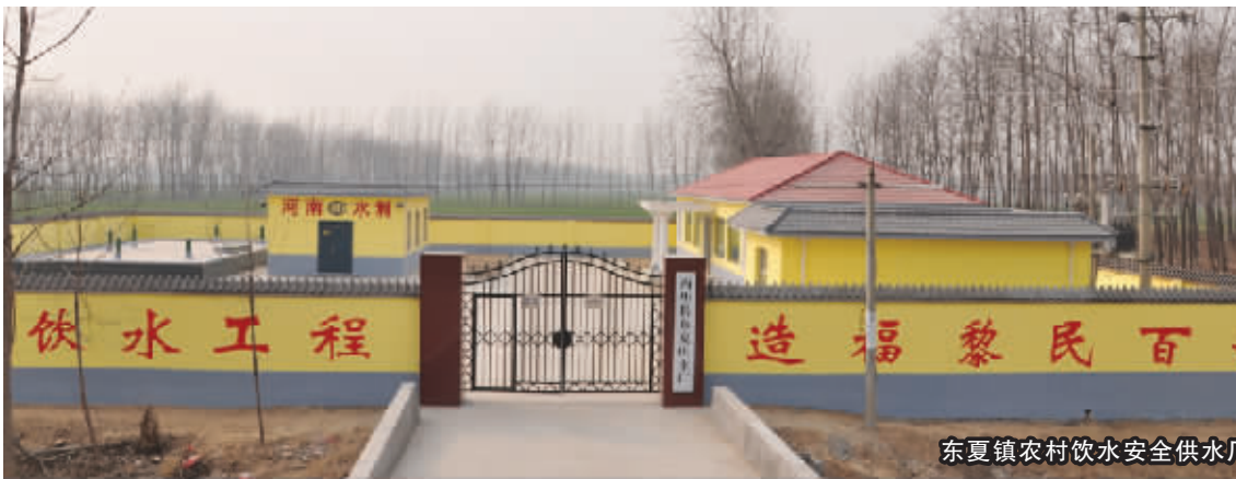
东夏镇农村饮水安全供水厂
