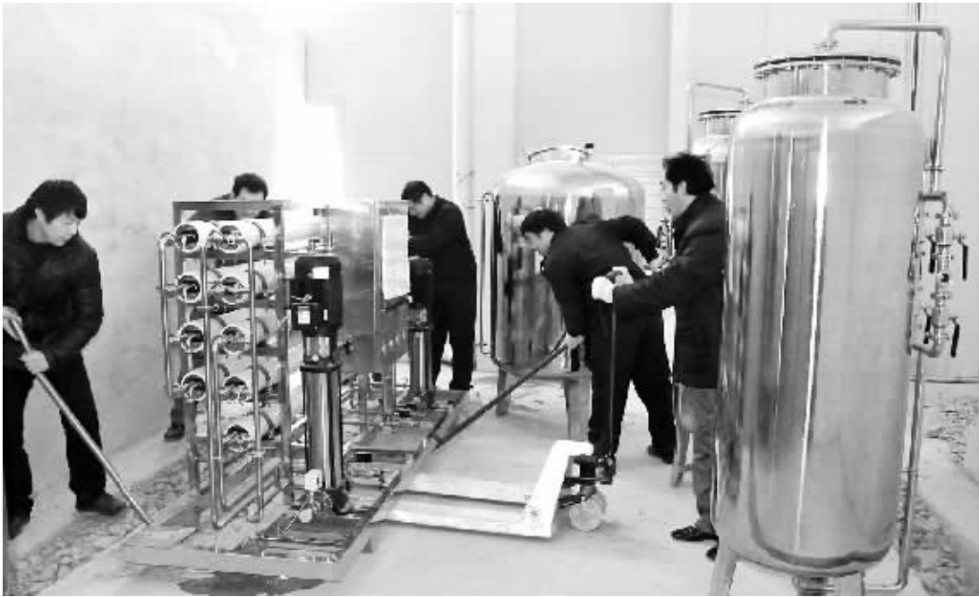
日前,在鹿邑县产业集聚区内,河南辅仁药业集团部分项目正调试安装。该制剂生产中心建成后可年生产口服制剂150亿粒(片),安排4000多人就业。(记者 沈湛 摄)
