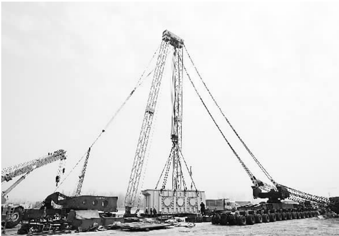
4月1日上午,周口500千伏变电站二期工程三相一体变压器通过水路顺利运抵周口港并成功起吊上岸,该变压器采用水陆联运的方式从沈阳、青岛、上海运至周口港,航程2250多公里。图为500千伏三相一体变压器在周口港起吊上岸的情景。(魏树林摄)
